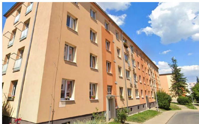
Jeden z dotčených panelových domů
