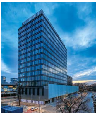
Polyfunkční centrum Einsteinova, Bratislava, Slovensko
