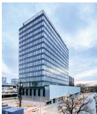
Polyfunkční centrum Einsteinova Bratislava, Slovensko
